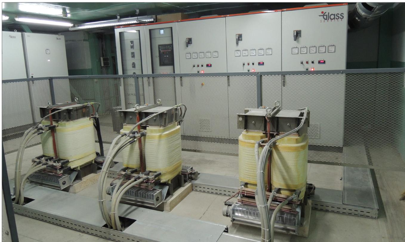
Тиристорный блок TU используется для систем малой мощности в диапазоне 30-400 кВА. Эта система значительно дешевле, чем установка OLTC.
